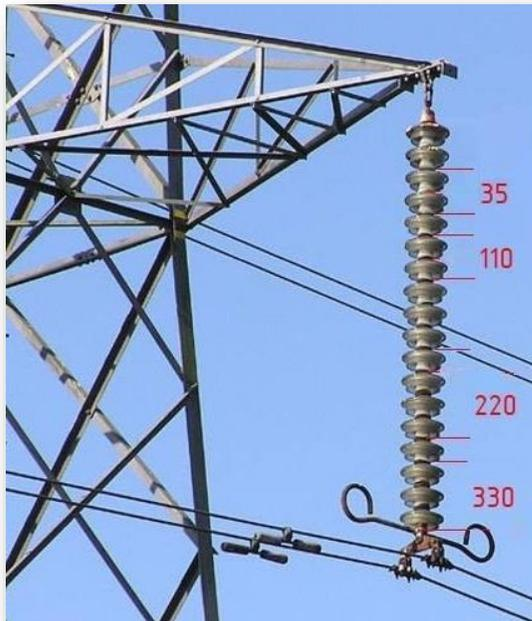
**Поверхность изолятора сконструирована так, чтобы создать максимальное сопротивление.**
